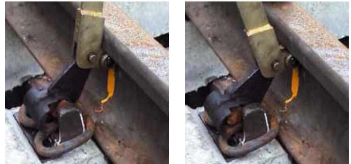
Рис. 18. Устройство для демонтажа монорегуляторов
